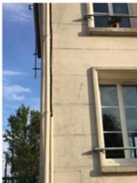
Photo 2 : Descente d'eau pluviale, mairie
