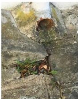
Photo 4 Sortie de la descente d'eau pluviale mairie
