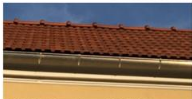
Photo 1 : Le toit et sa gouttière, rue des Petits Poiriers
