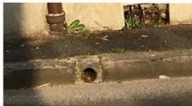
Photo 5 Sortie d'eau vers le caniveau
